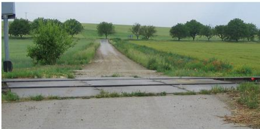
Obr. 2 Betónová priecestná konštrukcia – žliabok tvorený betónovým priecestným panelom
