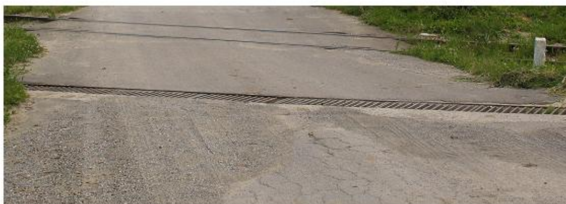
Obr. 6 Úprava odvodnenia pred priecestím so zachytením nánosov
