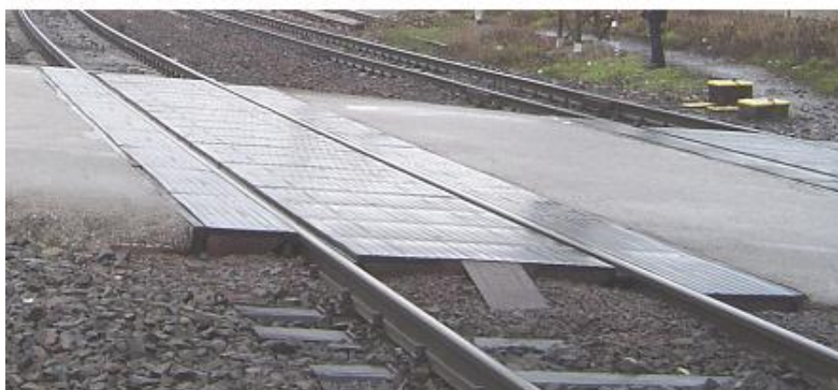
Obr. 4 Gumokovová priecestná konštrukcia – žliabok tvorený gumokovovým priecestným dielcom
